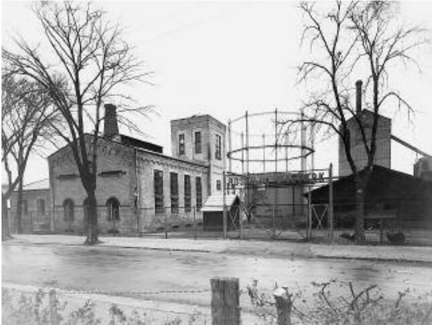
Roskilde Gasværk under moderniseringen i 1931. Bemærk, at den store gas-tank endnu ikke er færdigbygget. Det nye gasværks større ledningsnet betød, at værket kunne levere gas til Himmelev og Sankt. Jørgensbjerg. Det gav flere kroner i Roskildes kommunekasse. Roskilde lokalhistoriske Arkiv.
